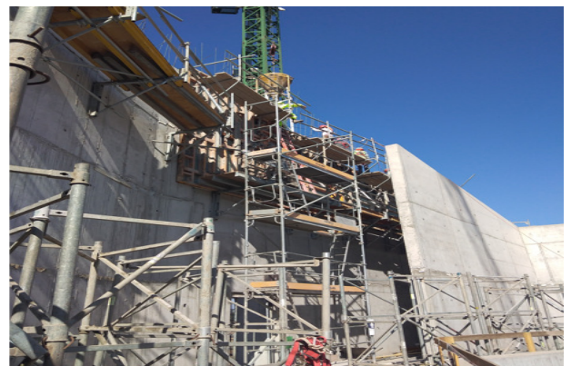
Hormigonado de muro eje U2/19-19a, piso 2, coronamiento, templo mayor.
