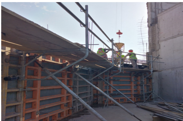
Hormigonado de muro eje 18/I-T2, piso 2, sector oratorio.
