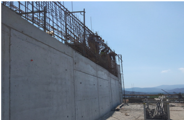
Avance armadura muro eje Q/5-16, piso 2, etapa 2 coronamiento, sector talleres.
