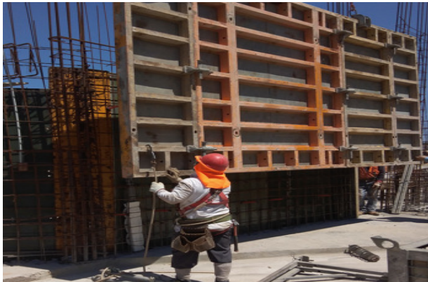
Instalación de moldaje 2° cara, muro eje 6/G-H3, piso 2, sector oficina.
