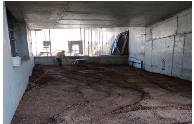
Construcción de relleno compactado, rampa acceso piso 1, ejes U2-L/5-19.
