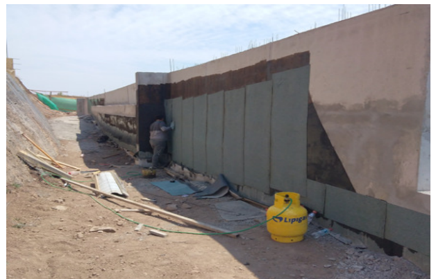
Instalación de membrana asfáltica en muro contraterreno eje 17C-H1, piso 1.
