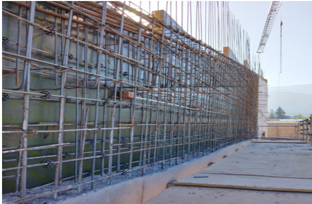
Instalación de moldaje muro eje U2/19-19a, etapa 3 coronamiento, templo mayor.
