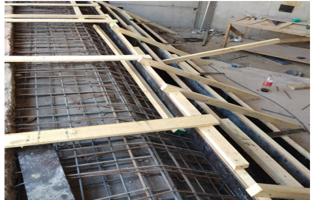
Moldaje escalera acceso N°03, piso 1, Templo mayor.
