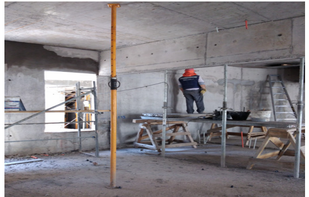
Descarachado y estuco muros piso 1, sector oficina contador.
