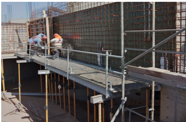
Instalación de moldaje 1° cara, muro eje 18/I-T2, piso 2, sector oratorio.
