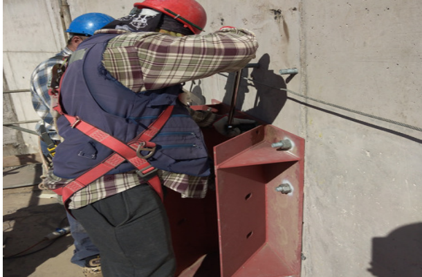
Instalación de soporte viga A, con eje 1, cielo templo mayor.
