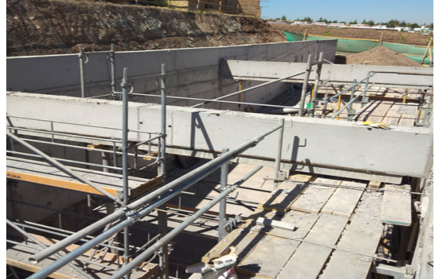
Desmolde vigas ejes J y K/16-17, sobre rampa vehicular.
