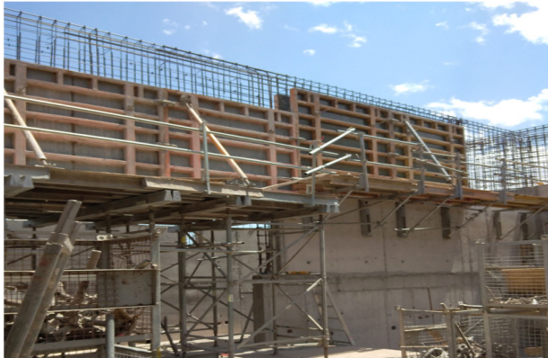
Instalación de moldaje muro eje P/11-19a, etapa 2, templo menor.
