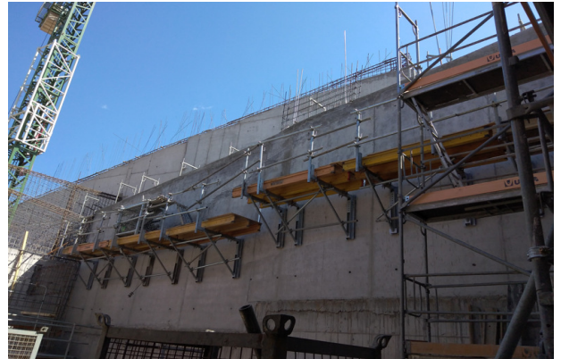
Descimbre muro eje L/11-19a, piso 2, etapa 2, sector bodega instrumentos.
