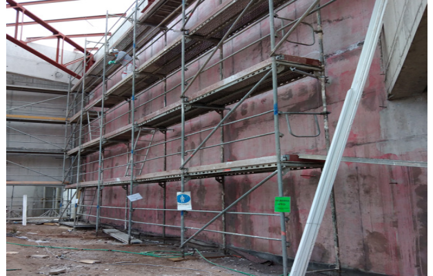
Limpieza de muro para enlucido con yeso, eje 5/Q-V, templo mayor.
