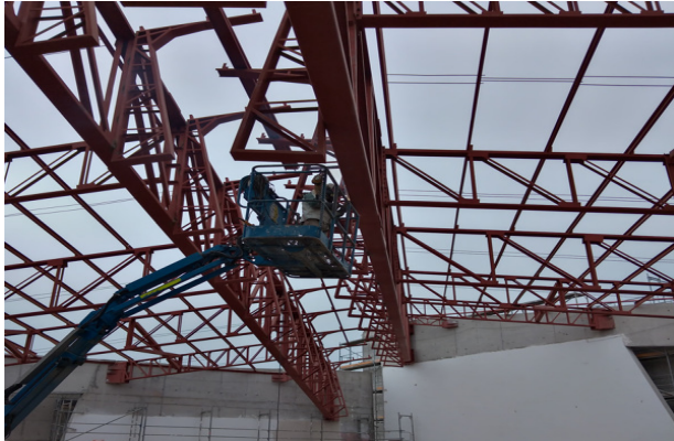
Soldadura cerchas curvas con viga eje A1, cielo templo mayor.
