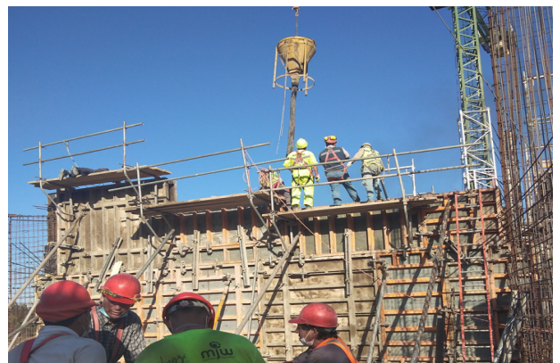
Hormigonado de muro eje 11/L-P, piso 2, sector patio descubierto.
