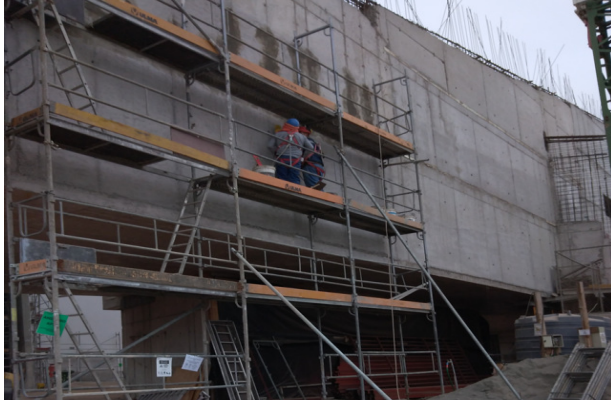
Preparación de muestra de muro exterior para pintura, acceso N° 02, templo mayor.
