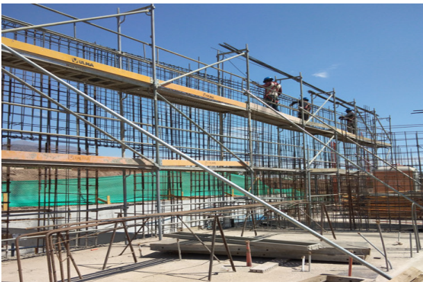
Avance armadura muro eje 16/J-Y1, piso 2, sector comedor y dormitorios.
