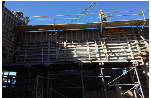
Hormigonado de muro eje P/11-19a, etapa 2, templo menor.
