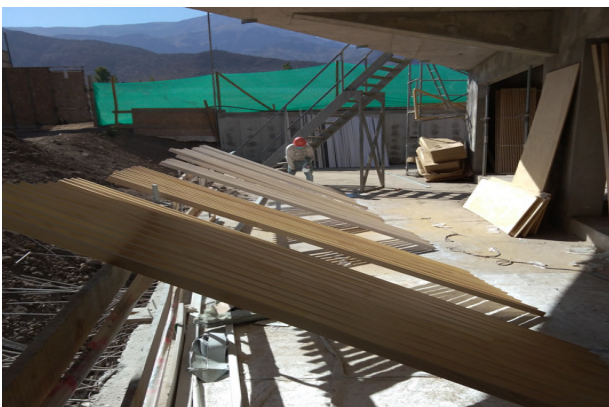
Avance fabricación paneles cielo de madera del templo mayor.
