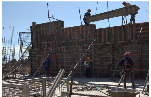
Instalación de moldaje muro eje 11/L-P, piso 2, patio descubierto.
