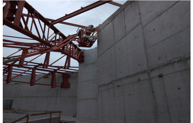
Montaje de vigas metálicas V14-V15-V16, sector coro, templo mayor.
