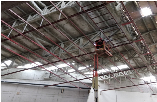
Avance en montaje estructura metálica secundaria, ala poniente, cielo templo mayor.
