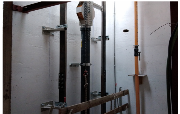
Avance montaje de soportes y guías, para equipo ascensor.
