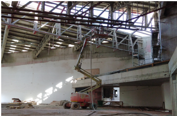
Avance aplicación de protección ignífuga, sector coro, cielo templo mayor.
