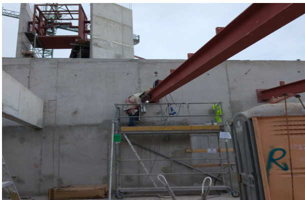
Montaje vigas metálicas, cubierta sector casa parroquial.
