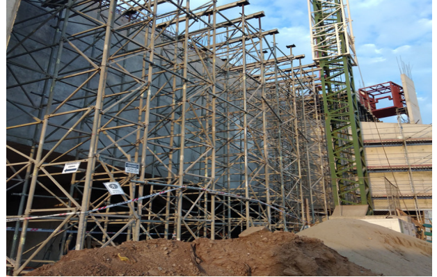
Armado de torres cimbra para losa alero eje U2/1a-19a
