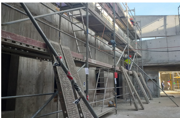
Instalación de andamios muro eje 6/S-L, patio descubierto piso 1.
