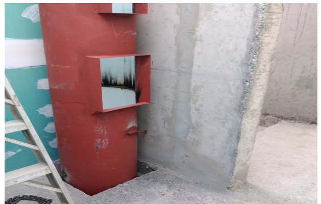
Instalación de ducto metálico, sistema de basura.
