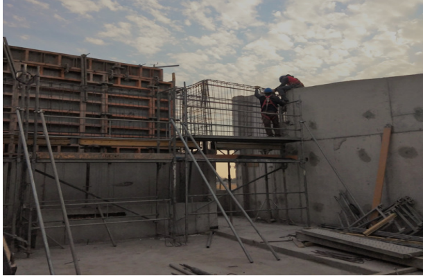
Avance armadura viga eje P/6-13, cielo piso 2, sector patio descubierto.
