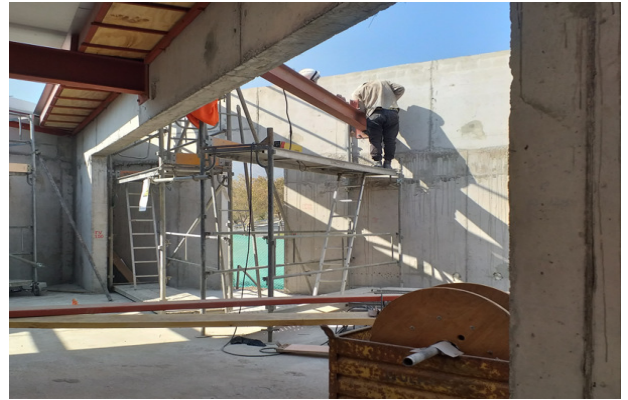
Montaje de viga metálica, cielo piso 2, sector taller 7.
