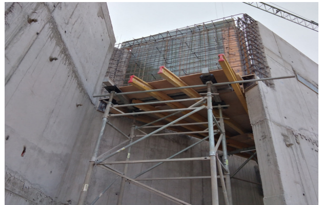
Instalación de moldaje 1 cara, muro eje X2/P-Y1, acceso N°06, templo menor.
