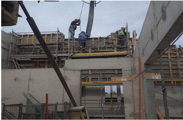
Hormigonado de muro eje O1/13-16, cielo piso 2, sector dormitorio 1.
